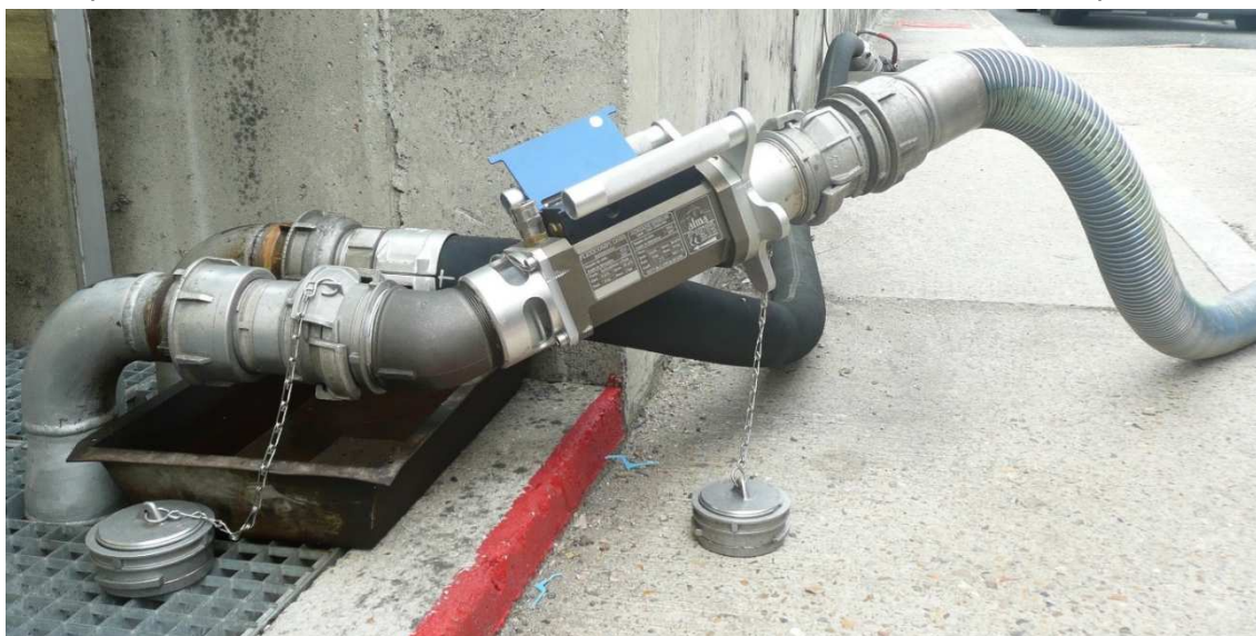
Rotation/axe longitudinal non conforme
