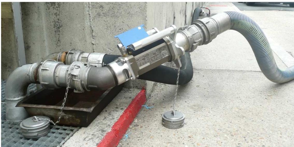
*Rotation/axe longitudinal non conforme*
